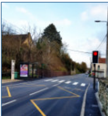
Carrefour du Mesnil : réfection et mise en sécurité
